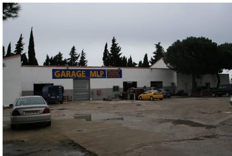
Photo 23 : Garage en bord de la RD914
