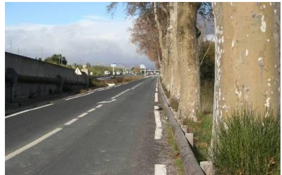
Photo 59:Voie longeant le RD 914
