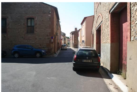
Photo 46 : Une grande part d'anciennes bâtisses ayant fait l'objet d'une réhabilitation
