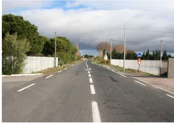
Photo 91: Arrêt de Bus Zone d'activité
