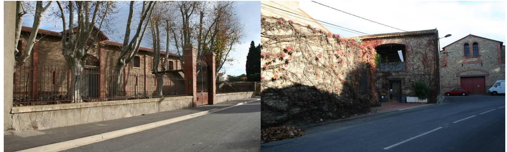
Photo 8 : Cave privée et bâti ancien transformé en habitation
