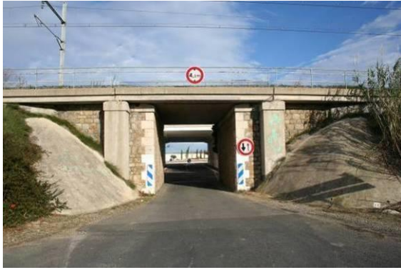
Photo 61: Tunnel sous la voie ferrée
