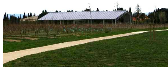
Photo 95 : Hangar agricole construit avec panneaux photovoltaïque près des 150Ilius
