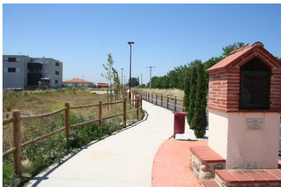
Photo 65 : Aménagement d'un cheminement « doux » sur la frange de « l'Oratori »
