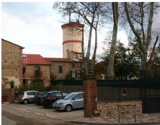
Photo 82 : Mairie et château d'eau
