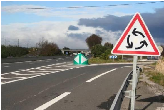
Photo 51 : Voie de décélération de la RD914 pour lier la RD39
